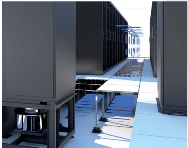
Klimaschränke mit Ventilatorsockel im Doppelboden
